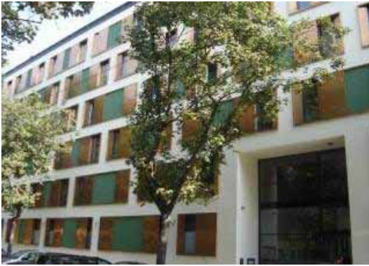
Abbildung 28: Westfassade (Quelle: LANG consulting)
