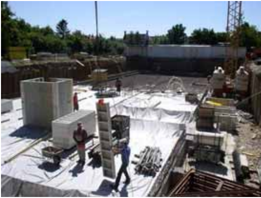
Abbildung 66: Bauphase (Quelle: Architekturbüro Reinberg)
