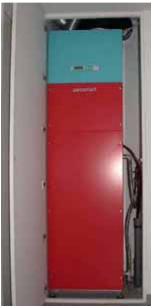
Abbildung 54: Kompaktluftungsgerät in Wohnung (Quelle: Treberspurg & Partner Architekten)
