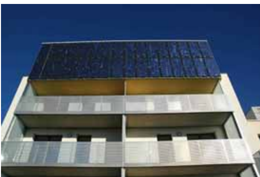
Abbildung 55: Photovoltaikanlage (Quelle: Treberspurg & Partner Architekten)
