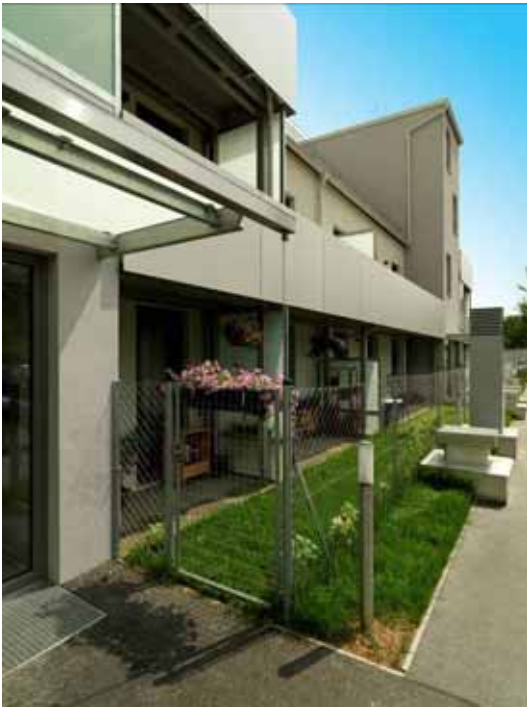
Abbildung 69: Eingangsbereich (Quelle: www.studiohuger.at)
