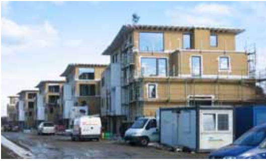
Abbildung 83: Bauphase (Quelle: Büro Hackermüller)
