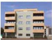
7. Fritz-Kandl-Gasse 1 BAI Bauträger Dietrich I Untertrifaller Arch.
