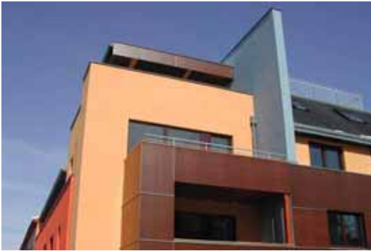
Abbildung 74: Detail Fassade (Quelle: Kresso)
