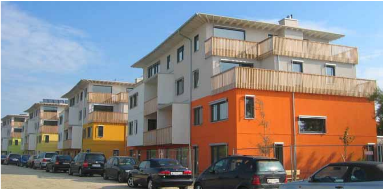
Abbildung 80: Ansicht Passivwohnanlage Esslinger Hauptstrasse (Quelle: BOKU)
