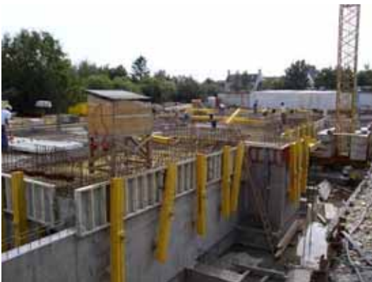
Abbildung 67: Bauphase (Quelle: Architekturbüro Reinberg)
