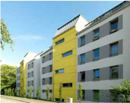
Abbildung 22: Straßenansicht (Quelle: www.studiohuger.at )
